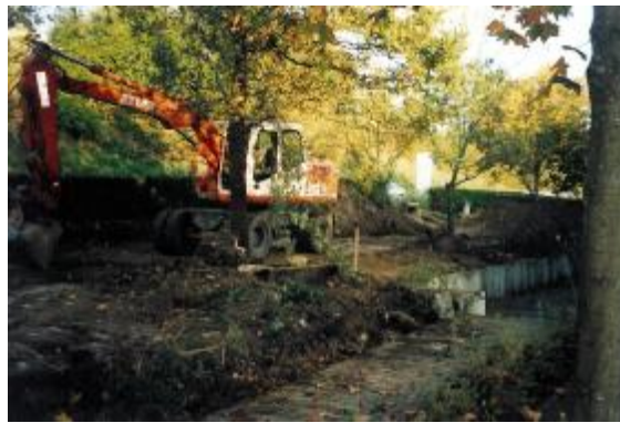
22.10.2001 Es geht los, der Bagger rückt an.
